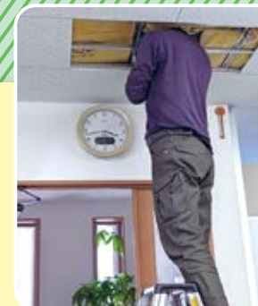
換気扇配線工事
