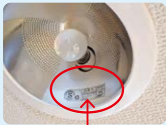
断熱施工対応型のLED電球が必要
