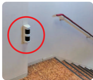
パッシブセンサーで人の動きを検知
