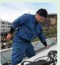
日向 (配線工事)
