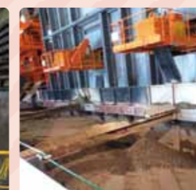
初めてのトンネル作業現場に興奮 土砂のふるい分け作業
